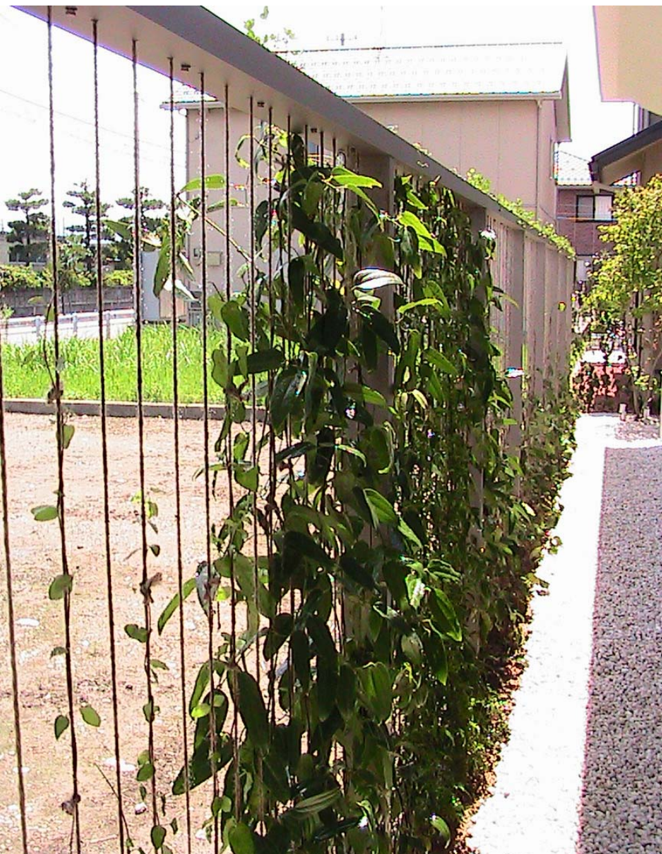
アルミ押出型材+SUSロープで構成
